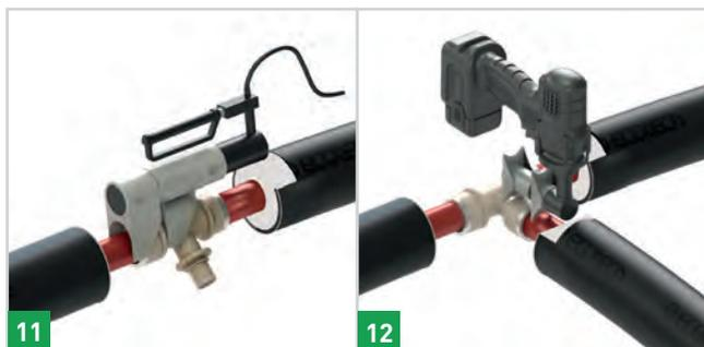
Sobald die Verbindung zwischen den Rohren abgeschlossen ist, wird die Muffe eingesetzt und die Isolierung an der Verbindung wiederhergestellt, wie im entsprechenden Absatz angegeben.
